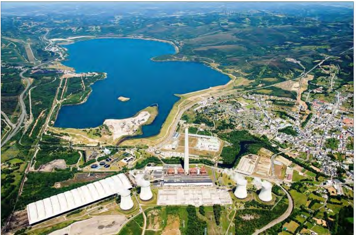
MINA DE AS PONTES DE GARCÍA RODRÍGUEZ. A CORUÑA.
