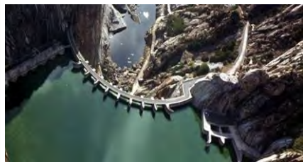
Presa de Aldeadávila, Salamanca, Iberdrola.
