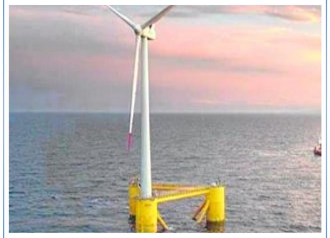
Colocados sobre plataformas flotantes triangulares de 3.500 toneladas de peso y 80 metros de longitud por lado, la altura del rotor de estos molinos sobre el nivel del mar sería de 142 metros y la de las aspas oscilaría entre 22 y 262 metros. El peso estimado del conjunto rotor-góndola es de 760 toneladas.
