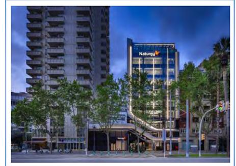
El diseño de la fachada sur incorpora un tratamiento de lamas fotovoltaicas, que "además de proteger del sol en los meses más cálidos del año, generan energía limpia para una parte de su consumo eléctrico".
