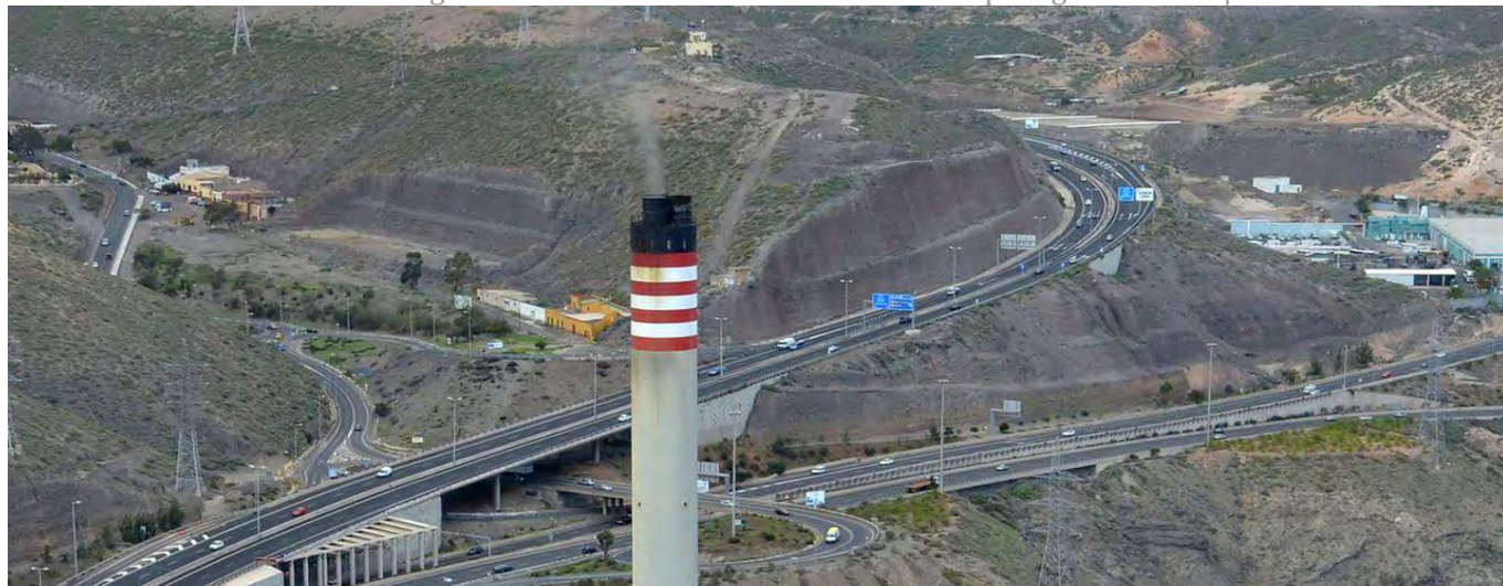
Central de generación de Endesa en la entrada a la capital grancanaria. |
