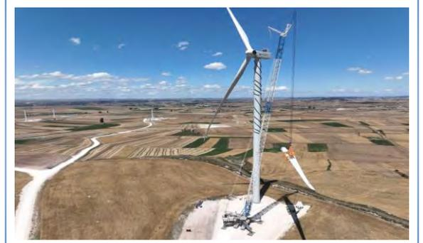
Inicia así el montaje de los **20 aerogeneradores** que integran esta instalación burgalesa de energía renovable cuyas palas tienen una longitud de más de 70 metros y la altura del aerogenerador duplica la de la Catedral de Burgos.
