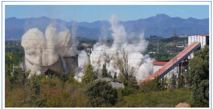
En la voladura de las torres el proceso ha sido aún más complejo, ya que ha estado soportado por un proyecto específico en el que se ha analizado estructuralmente la afección de los trabajos preparatorios, así como la dinámica de la voladura, su secuencia, direcciones de caída, medidas mitigadoras de las afecciones, medidas de vibraciones y puesta en seguridad de todos los elementos y estructuras afectadas.
