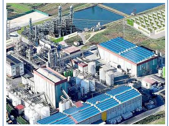
El metanol de FlagshipONE se producirá utilizando electricidad renovable y dióxido de carbono biogénico procedente de Hörneborgsverket. Además, FlagshipONE utilizará vapor, agua de proceso y agua de refrigeración de Hörneborgsverket. El calor sobrante del proceso de producción de etanol se devolverá a Övik Energi y se integrará en su sistema de calefacción urbana.
