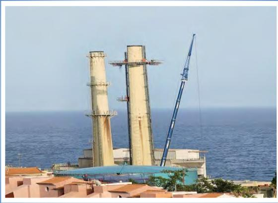
En cuanto a las características técnicas de la chimenea a demoler destaca su altura de 76,5 metros. La chimenea tiene forma de tronco cónico con un diámetro en su base de 6,22 metros y de 3,70 metros en su coronación. El espesor del fuste también es variable comprendido entre los 0,48 metros en su base y 0,20 metros en coronación.
