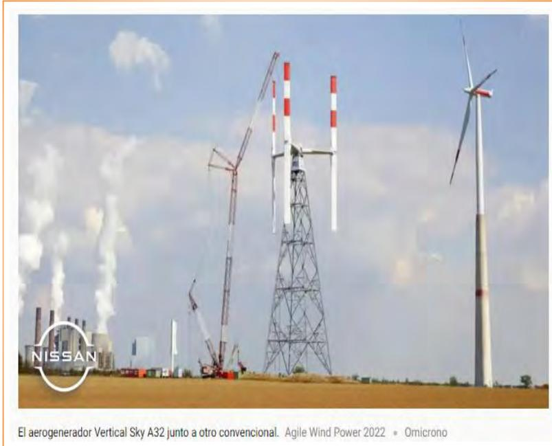
El aerogenerador Vertical Sky A32 junto a otro convencional. Agile Wind Power 2022 - Omicrono
