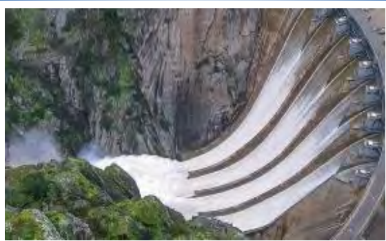
Central hidroeléctrica de Iberdrola en Aldeadávila.
