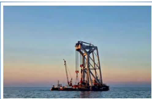
Iberdrola ha instalado los **cincuenta monopilotes del parque eólico marino Baltic Eagle**, en **Alemania**. Con un diámetro de 8,75 a 9 metros y una longitud de entre 75 y 90 metros, aseguran que las turbinas eólicas estén ancladas de forma segura al fondo marino.
