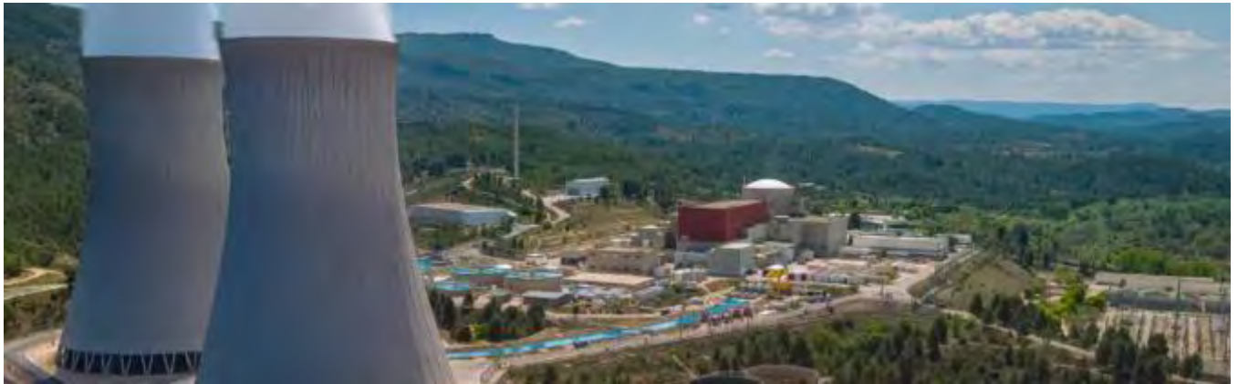
Panorámica de la central nuclear de Cofrentes.
