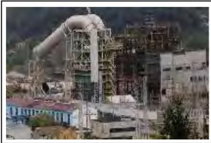
El desmantelamiento de la central térmica de Lada ya supera el 90% de ejecución. Tres años y medio después de que empezaran los trabajos queda pendiente finalizar el desmontaje de la caldera, de 80 metros de altura, y del sistema de desulfuración, asegura Iberdrola, la empresa propietaria. A finales de 2021 comenzó la actuación en la antigua planta langreana, que entra ahora en la recta final.
