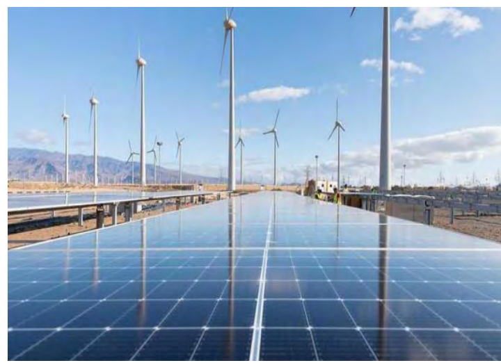
Imagen de una instalación de plantas fotovoltaicas.
