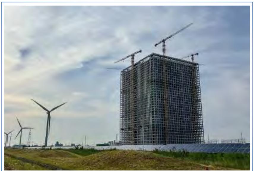
energía mediante bloques de hormigón que se elevan y descenden utilizando grúas, generando electricidad gracias a la fuerza de la gravedad. A diferencia de otras soluciones de almacenamiento, este sistema destaca por su escalabilidad y bajo impacto ambiental.
